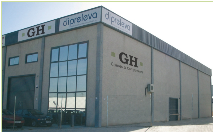
Centro de distribuição e peças de reposição da GH
